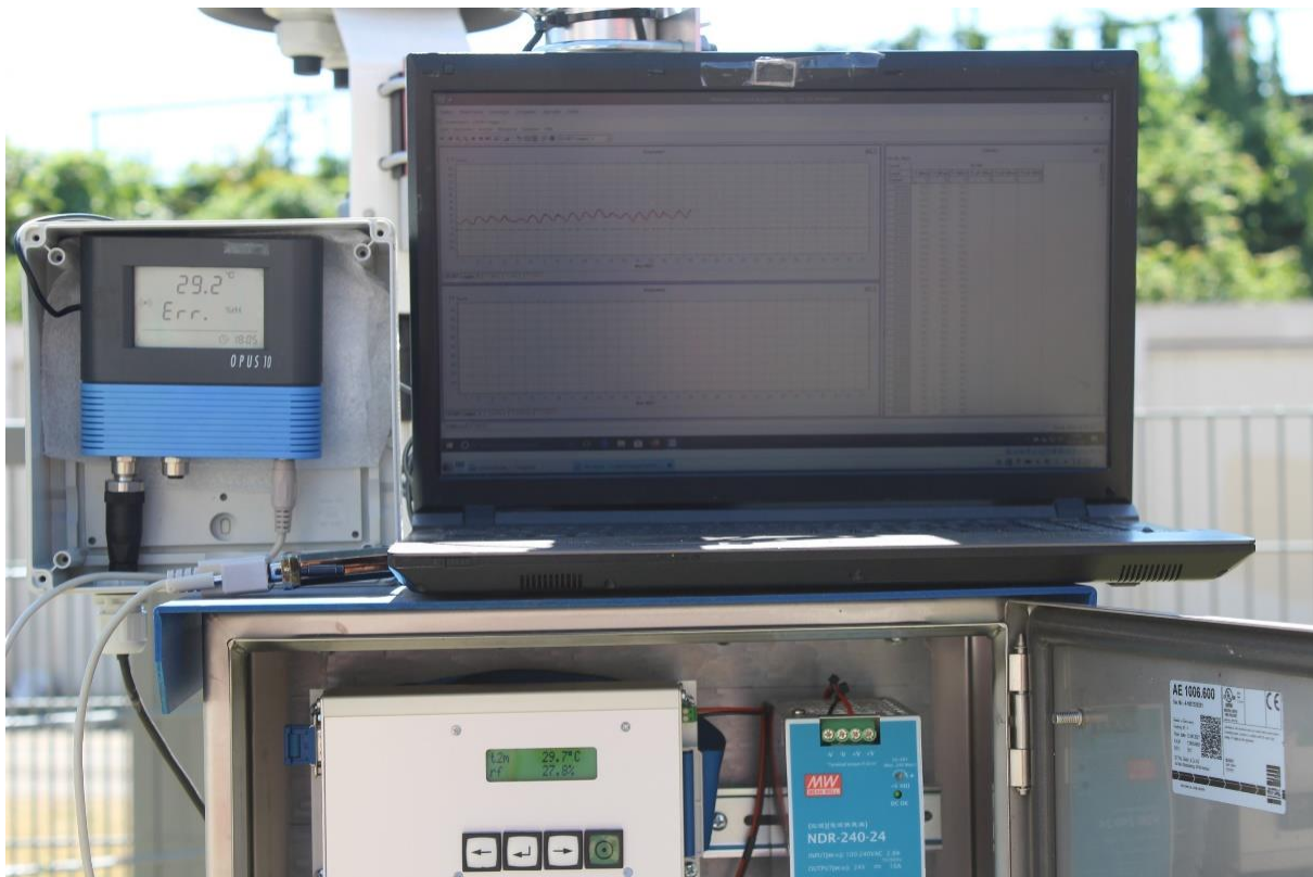
Abb. 3: Messsysteme an der Stadtklimastation „Schlossgartenstraße“ (FB 61)
